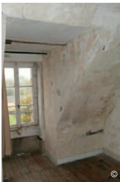
Deuxième étage des bâtiments conventuels © Abbaye de Mundaye
