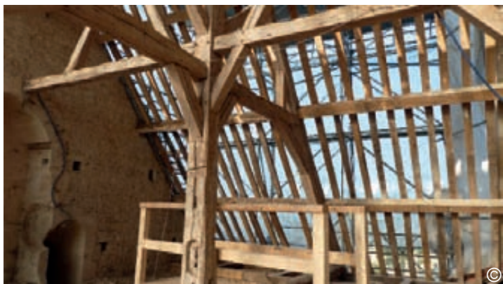
Réfection de la charpente de l'église abbatiale © Abbaye de Mondaye
